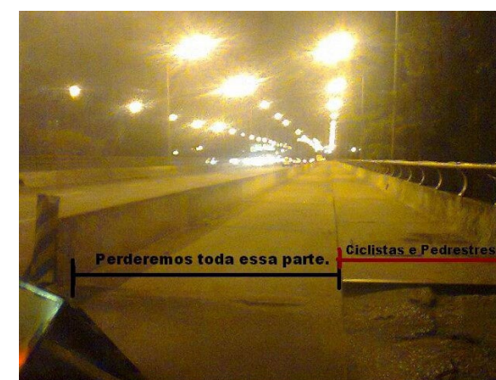
Alargamento da Ponte Juscelino Kubitschek
